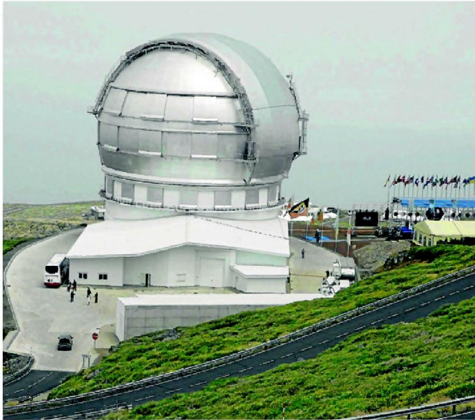
Situación: El Gran Telescopio Canarias (GTC) está situado en el Observatorio del Roque de Los Muchachos, en la isla de La Palma
